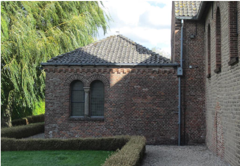
De aangebouwde consistorie
