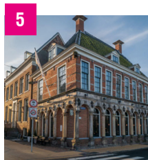
CORPS DE GARDE OUDE BOTERINGESTRAAT 72 ZATERDAG 10.00 - 17.00 Monumentaal pand, in 1634 gebouwd als wachthuis voor militairen en stadswachters die de noordgrens van de stad bewaakten. Nu in gebruik als hotel. Zaterdag 11.00 Grunneger Volksverhoalen door Vertelcollectief Kom op Verhaal
