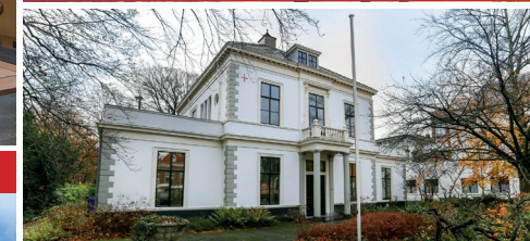
Verbouwing monument Voorburg
