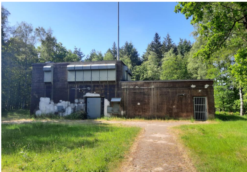
Commandobunker vliegbasis Soesterberg
