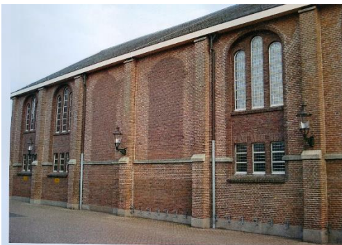
Aan de buitenzijde is duidelijk te zien dat er twee vensters zijn dichtgemetseld.
