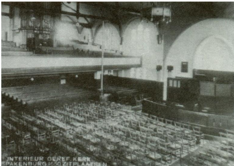
Het interieur na de verbouwing. Het orgel staat hier nog helemaal achterin. Als een nieuw orgel wordt aangeschaft komt dat meer naar voren, op de huidige plaats.
