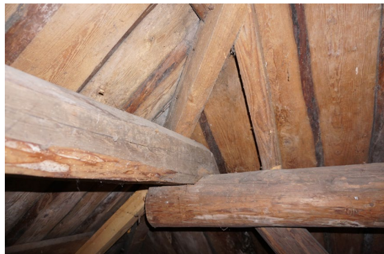
Deel van kapconstructie
