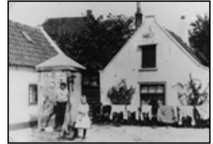
De dorpspomp bij het Schelpenplein is niet meer aanwezig.
