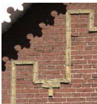
Detail van de in de voorgevel gemetselde 19e-eeuwse lijst van gele baksteen.
