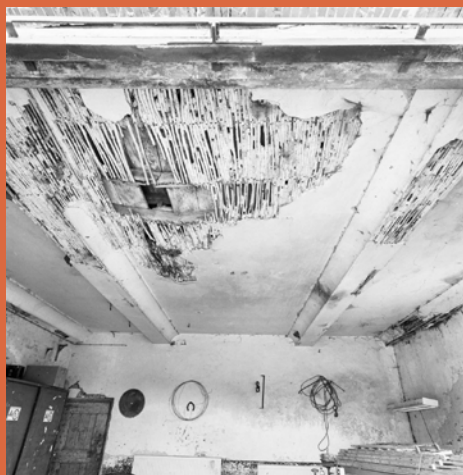
Stucplafond aangebracht op riet (foto RCE)
